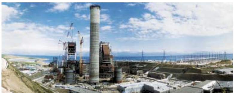
Großbaustelle des STEAG-Steinkohlekraftwerkes Iskenderun, Türkei
